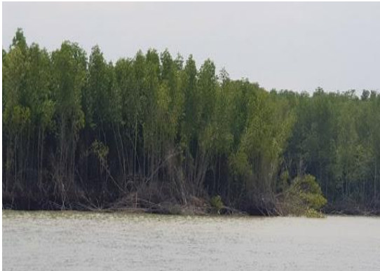
Hình 11. Sạt lở trên bờ sông Ngã Bảy
